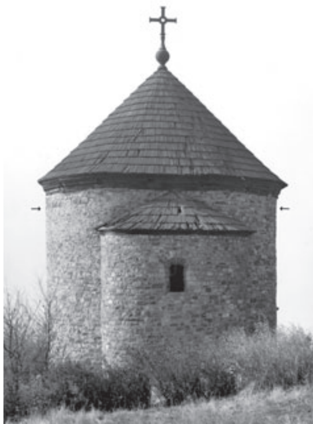
Obr.1: Starý Plzeň, rotunda sv. Petra od východu po rekonstrukci v letech 1921-1923, šipkami vyznačena spára na bázi obvodového věnce v horní části lodi. Foto z Archivu Města Plzně, fond fotografií, evid. č. 330/141, autor neznámý.
