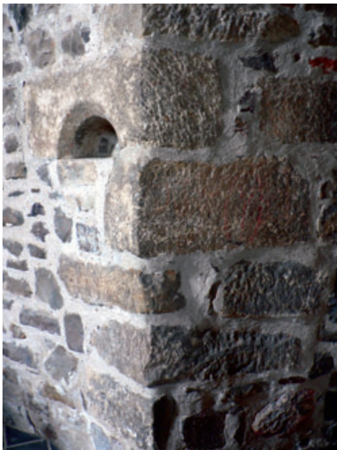
Obr. 7: Rotunda sv. Petra, levá špaleta vstupu do lodi s druhotně použitými pískovcovými kvádry a tesaným románským článkem. Foto autor, červen 2006.
