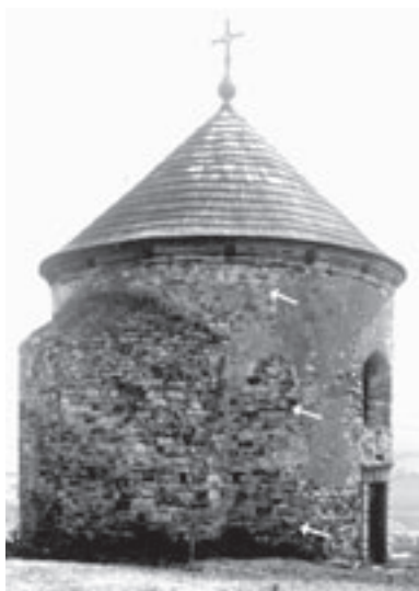
Obr. 4: Rotunda sv. Petra od severovýchodu, stav před rokem 1921, šipkami vyznačena spára mezi románskou a novověkou částí pláště lodi. Foto z archivu Národního památkového ústavu v Praze, inv. č. 1554, autor neznámý.
